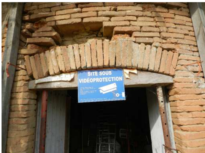
←---L'arc segmentaire avant son remplacement
